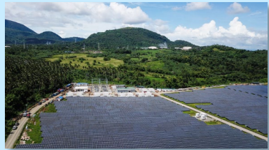
Laguna Alaminos Solar
